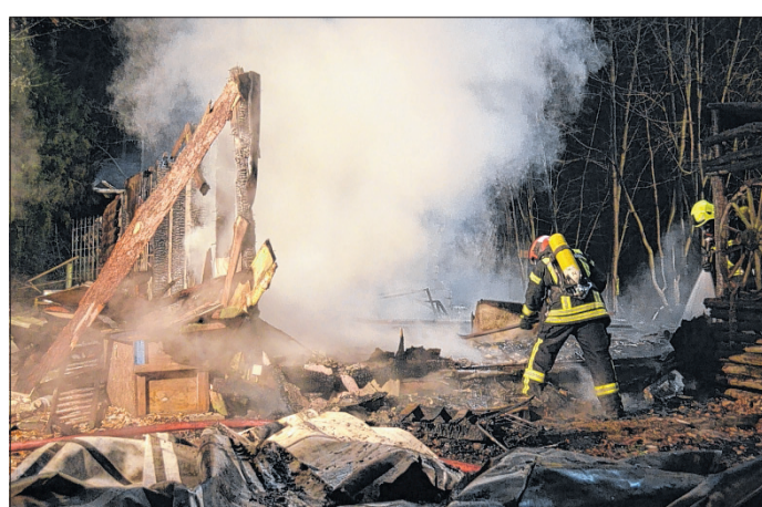
Trotz des Einsatzes mehrerer Feuerwehren wurde das Vereinsdomizil zerstört. Ein Kamerad erlitt schwere Verletzungen. Foto: Feuerwehr
